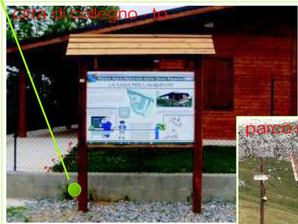
il pannello realizzato in perline maschiate è inserito ad incastro sui montanti laterali
