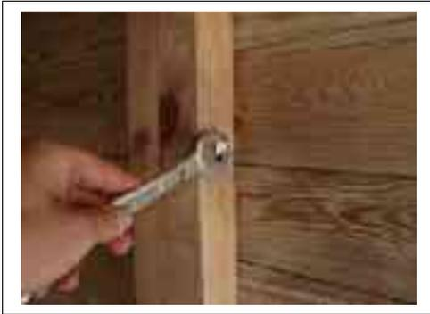
3) completare l'installazione dei pannelli laterali e di quelli sul retro con l'utilizzo dei bulloni passanti.
